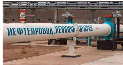
Введение в эксплуатацию магистрального трубопровода Кенкияк – Атырау
